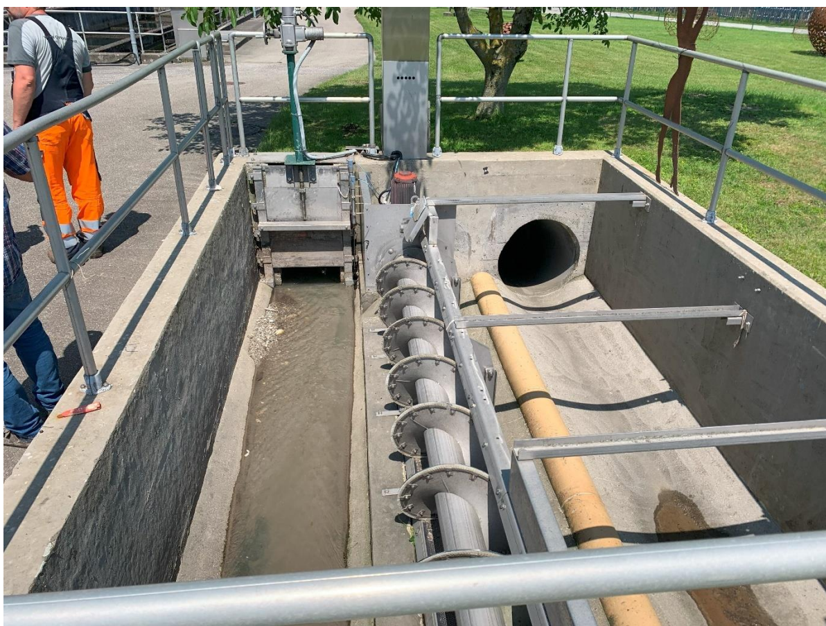
Abbildung 2: Zulaufbauwerk der Kläranlage
